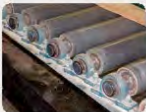
Перегрев подшипника конвейера
